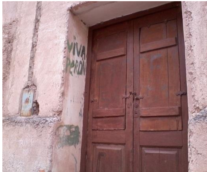
Portón con intervención
